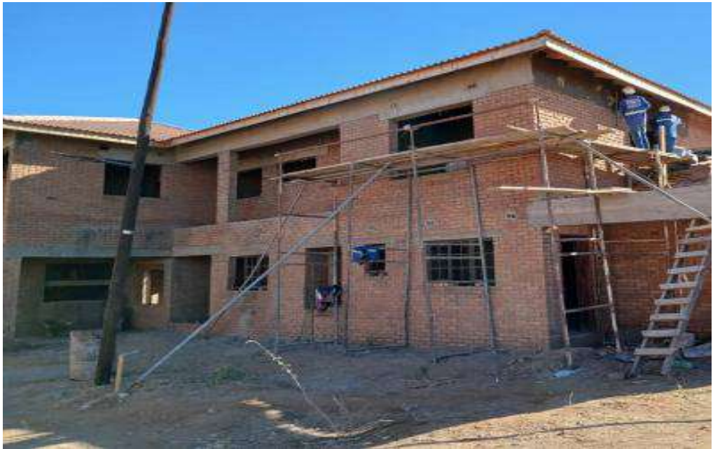
Beitbridge Duplex Flats
